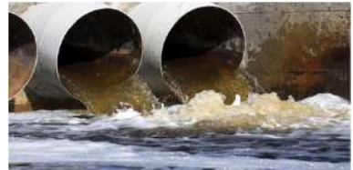
Figura 2. Aguas residuales [Fotografía], por Tecnología Del Agua, I. M. (s. f.) (HYPERLINK " https://www.gob.mx/imta/articulos/La-actualizacion-de-la-norma-sobre-descargas-de-aguas-residuales?idiom=es " https://www.gob.mx/imta/articulos/La-actualizacion-de-la-norma-sobre-descargas-de-aguas-
