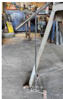
Fig. 6. Construcción del agitador de paletas en taller de herrería - Elaboración propia
