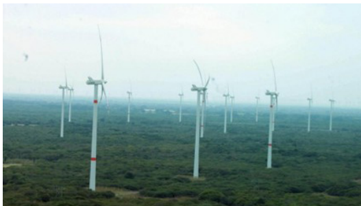
Figura No. 7. Parque eólico, Oaxaca, México. https://www.elorienten.net/home/2012/10/31/inauguran-centrales-eolicas-la-venta-iii-y-oaxaca-i/
