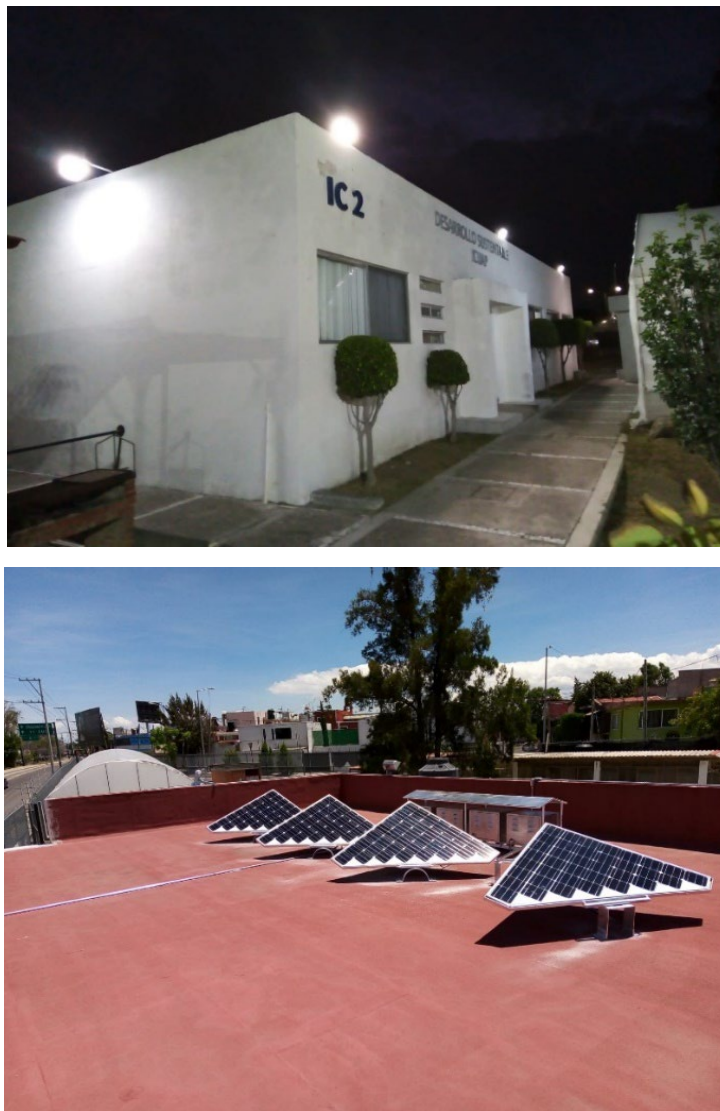
Imagen 8. Puesta en marcha de las luminarias nocturnas provistas con energía solar en los edificios IC 2 e IC 12.
